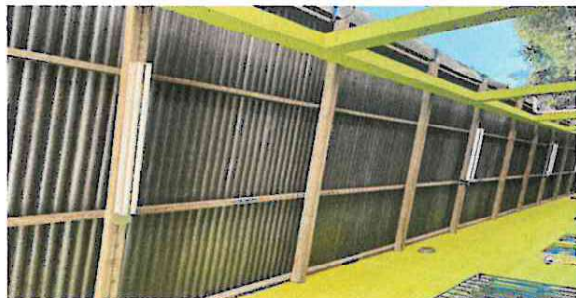
Foto 7: Reparación de cableado eléctrico, no tenemos electricidad en varias aulas ya que el cable está quemado.
