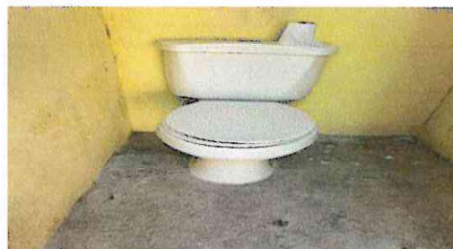
Foto 6: Sustrucción de inodoro porque estan quebrados de la parte inferior y esta medio colocado.
