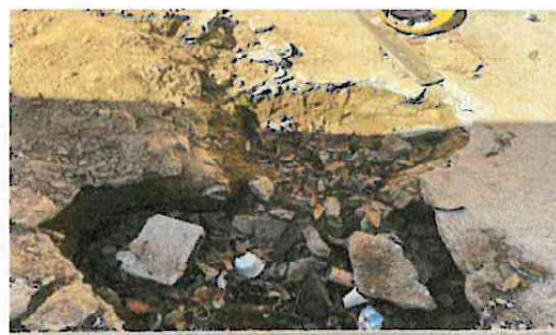
Foto 2: Sustrucción de tubería PVC línea principal aguas negras. Ya que la tubería es muy pequeña y ya esta podrida.
